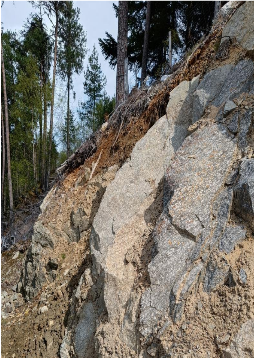
Fig. 7. Sprengkant i vestre sida av Beimshaugen syner Solvorngranitt.
