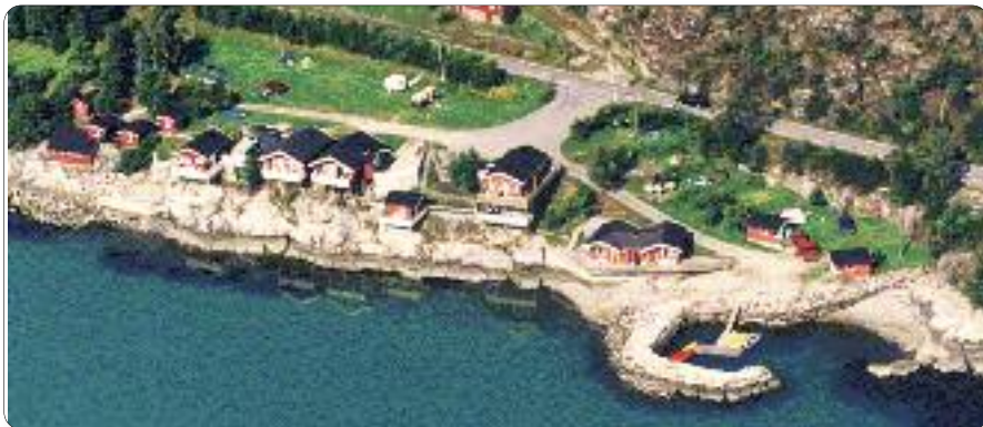
Viki Fjordcamping har fått lån til å bygge nytt sanitæranlegg.
