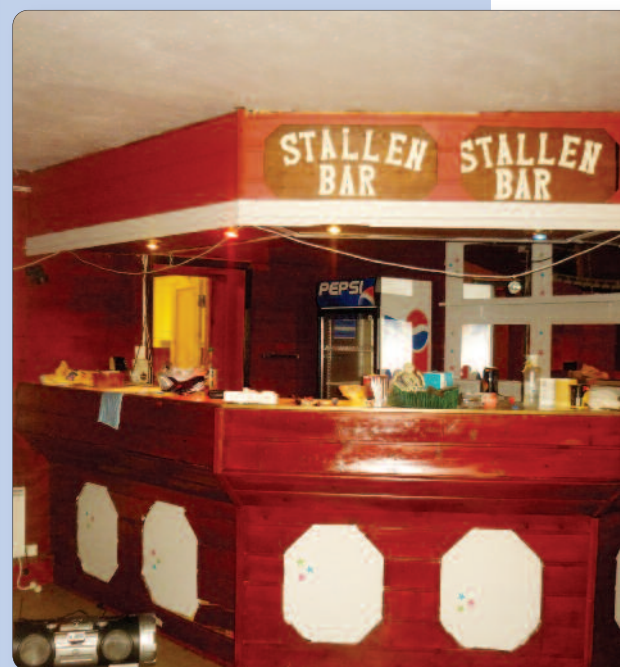
Under oppussing, her er det salg av kioskvarer.
