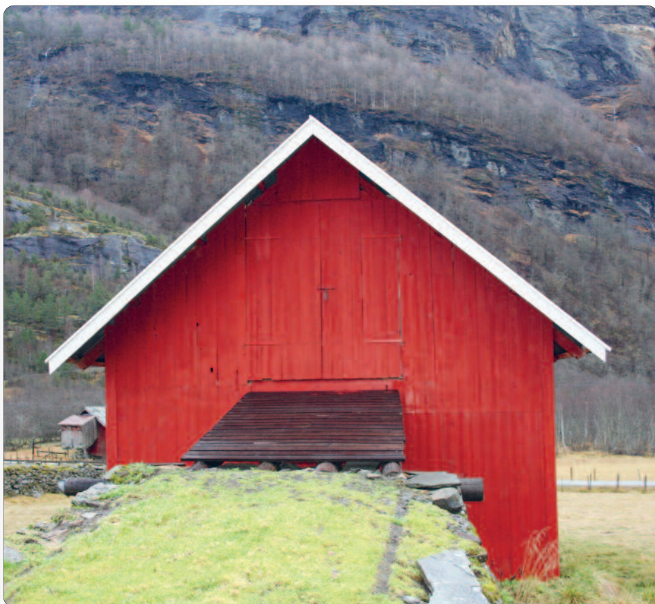
Løe etter restaureringa.
