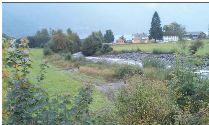
Nye Dale vassverk.
