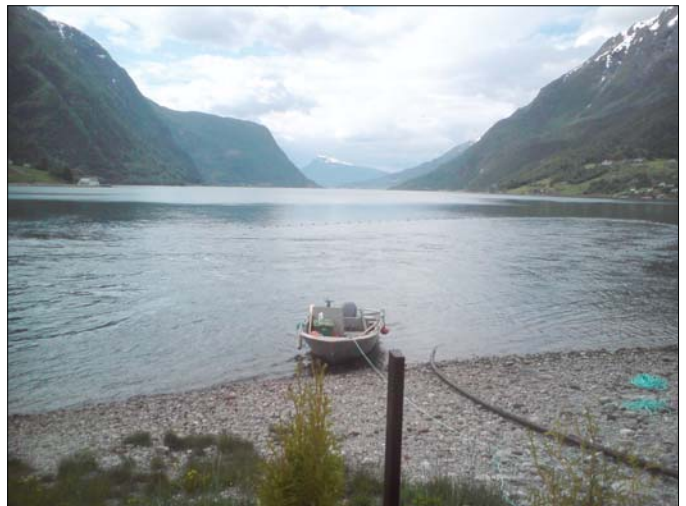
Omlegging av va-leidningar Eidselvi, Skjolden.
