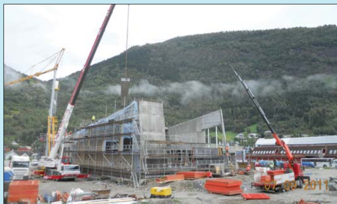
Bygget under oppføring. Store dimensjonar.
