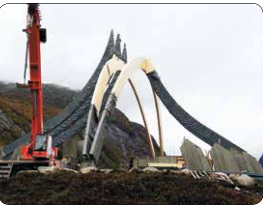
Limtrebogane kom på plass i slutten av september 2012.
