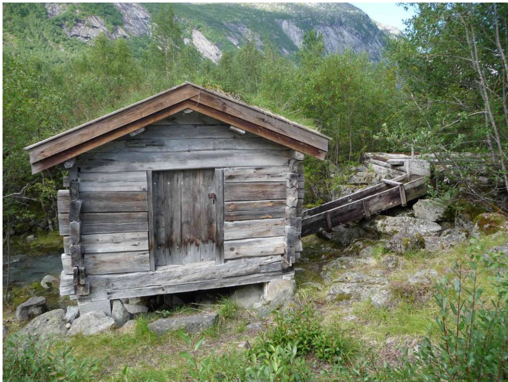
Kvernhuset som Jostedalen Historielag har restaurert. Foto: Tom Dybwad
