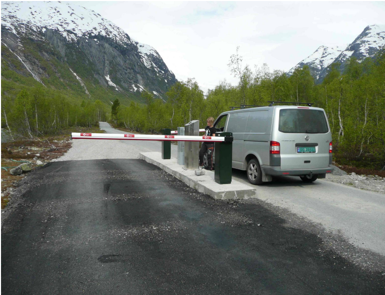
Ny sjølvbetjent vegbom (2014) for Brevegen AS. Foto: Tom Dybwad
