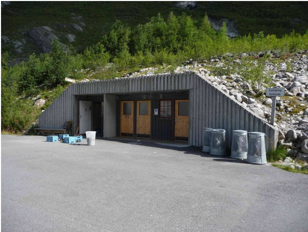
Service- og toalettbygget ved parkeringsplassen.
