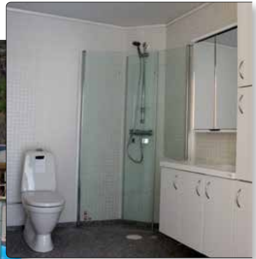
Bad. Montasjearbeid innvendig pågår for fullt.
