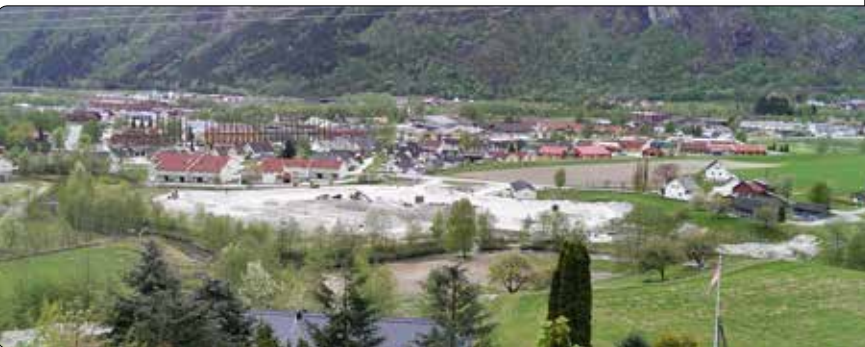
Nytt byggjefelt Verket 2. Ferdigstilt sommaren 2016.
