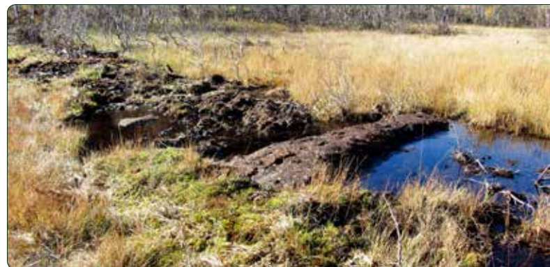
Å tetta grøfter er omvendt av det vanlege, men i Yngsdalen har ein gjort det for å heva vasstanden i myra og hindra attgroing.
