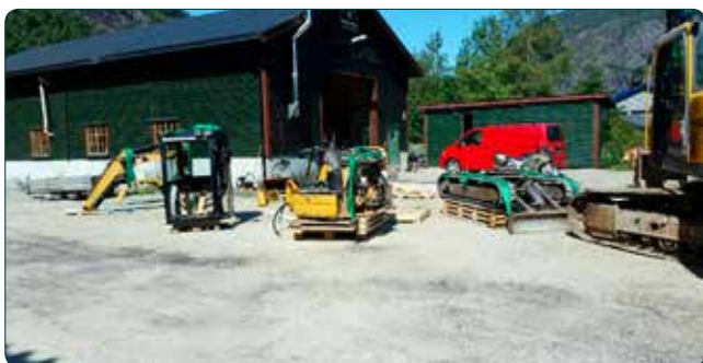
Her er gravemaskina demontert og klar for helikopterløft.
