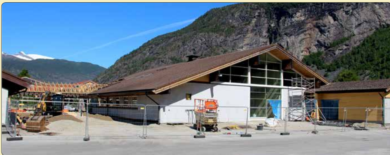
Friskhuset, hovudfasade med inngang i mellombygg. Ein del år tilbake vart dette brukt som yrkesskulebygg.
