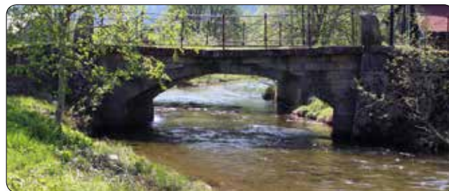
Engjadalselvi har vore kryssa av heile sju bruer i sentrumsområdet. Nedst er brua som vart bygd i samband med etablering av djupvassutslepp i fjorden, så kjem brua over fylkesveg 55 og den nye gangvegbrua, så kjem den gamle fylkesvegbrua og den enno eldre kvelvingsbrua som no er gangbru. Ved Hanaskjeren er det også ei gangbru og siste brua(ene) er brua på Engjadalsvegen ved Tandle.
