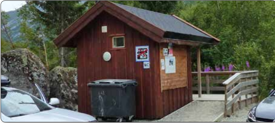
Servicebygget på Bergset, Jostedal er eit av fleire anlegg som har fått finansiering gjennom spelemiddel-ordninga.
