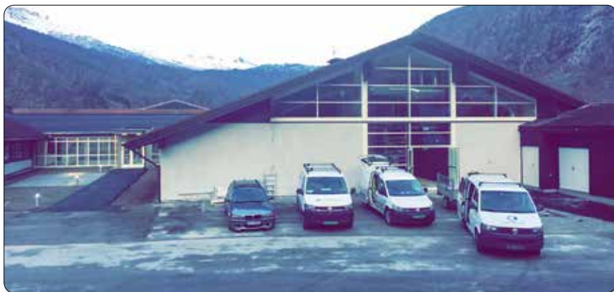
Gamle yrkesskulen, midtbygget og øvste delen mot Øyagata, er bygd om til Friskhuset og skal huse Luster Trening, Frisklivssentralen Sogn, Luster Frivilligsentral og fleire fysioterapeutar.
