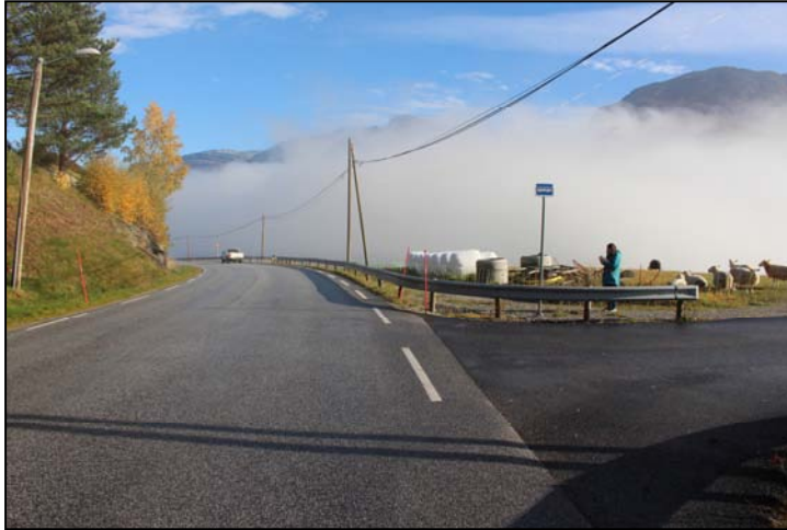
Krysset mellom V2 og V3 ligg på det høgaste punktet på FV55 i området.
