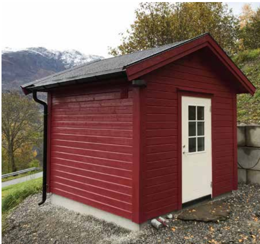
Styringsstasjon for nye Dale vassverk ligg i Bringebakkane.
