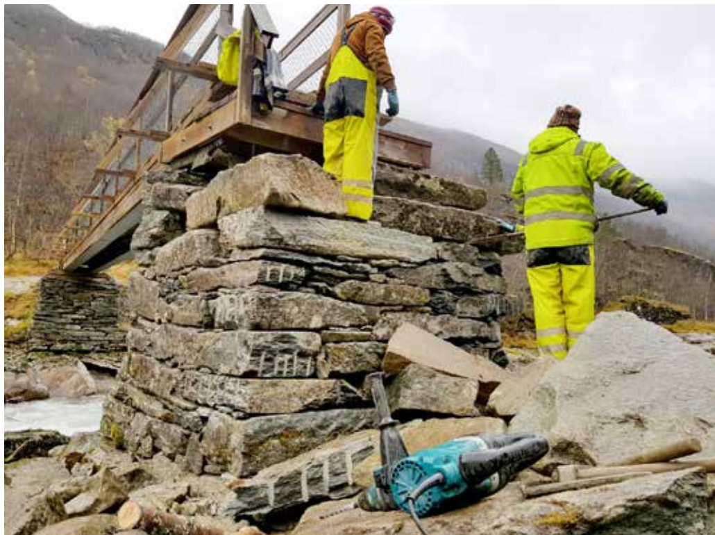
Bygging av nytt bru-kar, eit samarbeid mellom Ødegård bygg og maskin og Stibygjaren. Foto: Rune Fuglesteg.
