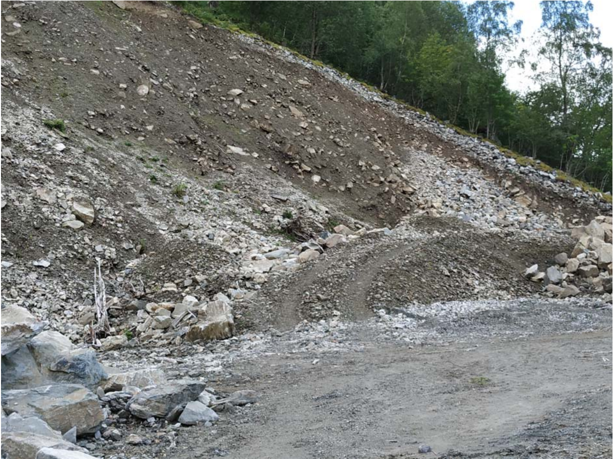
Bredden av massetaket sett mot vest
