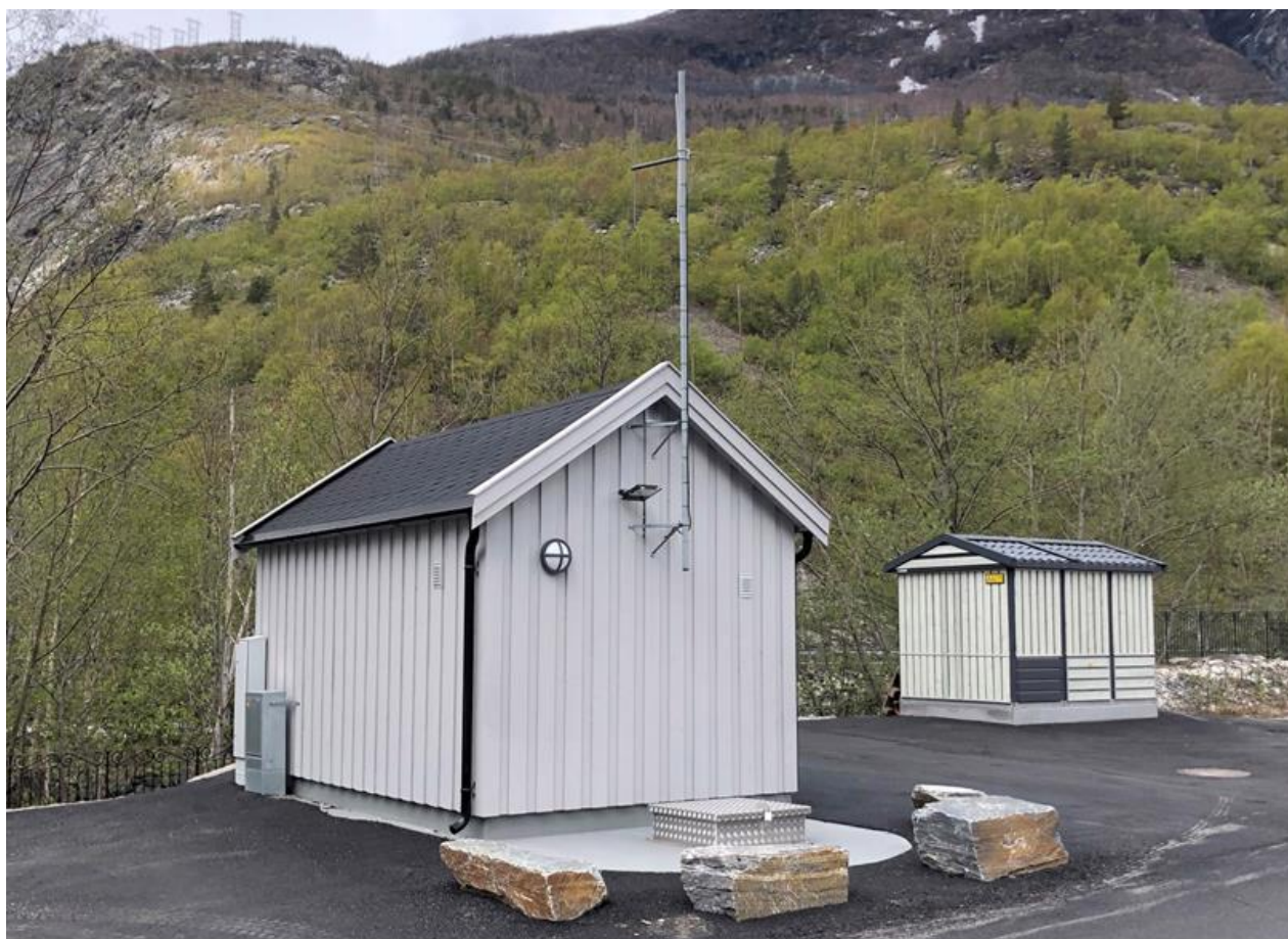
Vee Avløpspumpestasjon, Årdal kommune
