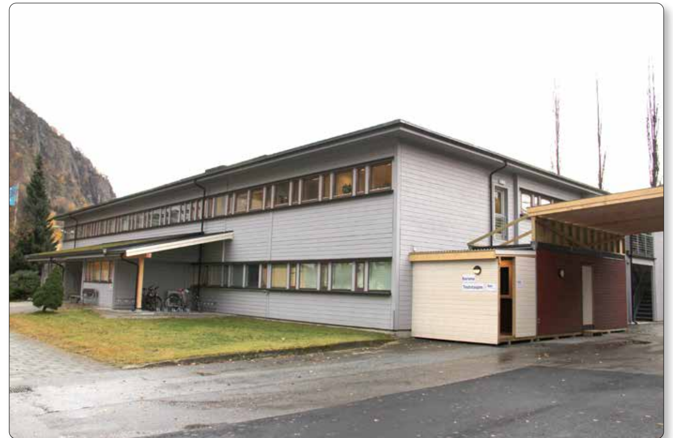
Det er etablert teststasjon ved Helseneteret i Gaupne. Per 04.11.20 er det teke 1051 testar i Luster. Du kan bestille Koronatest via heimesida til kommunen eller ringe 906 72 675. (Kl. 8–15)
