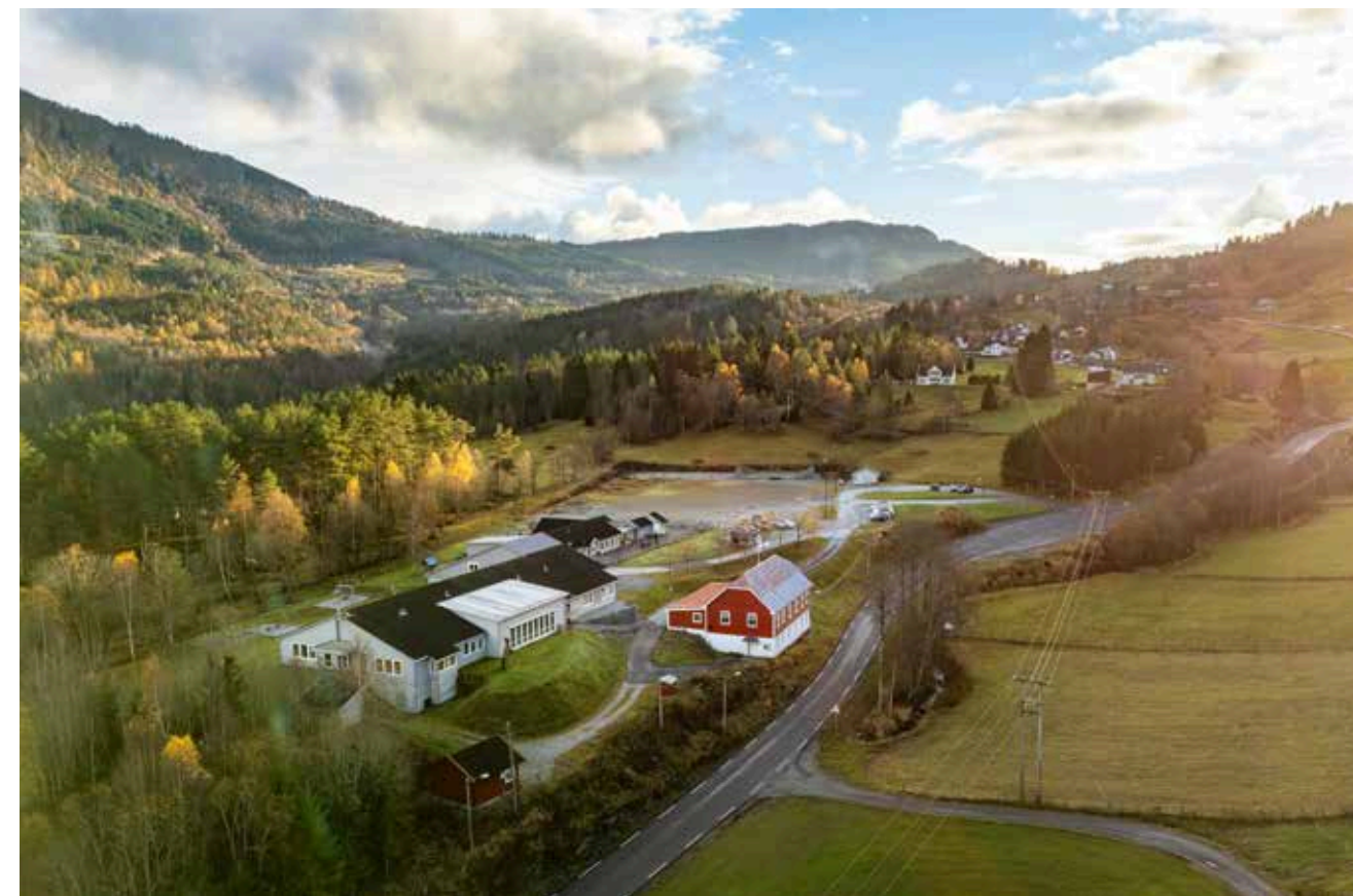
Indre Hafslo oppvekstsenter. Foto: Ørjan Talle
