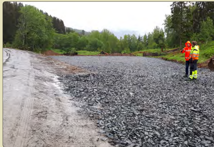
Under arbeidet med utviding av parkeringsplass på Krossen
